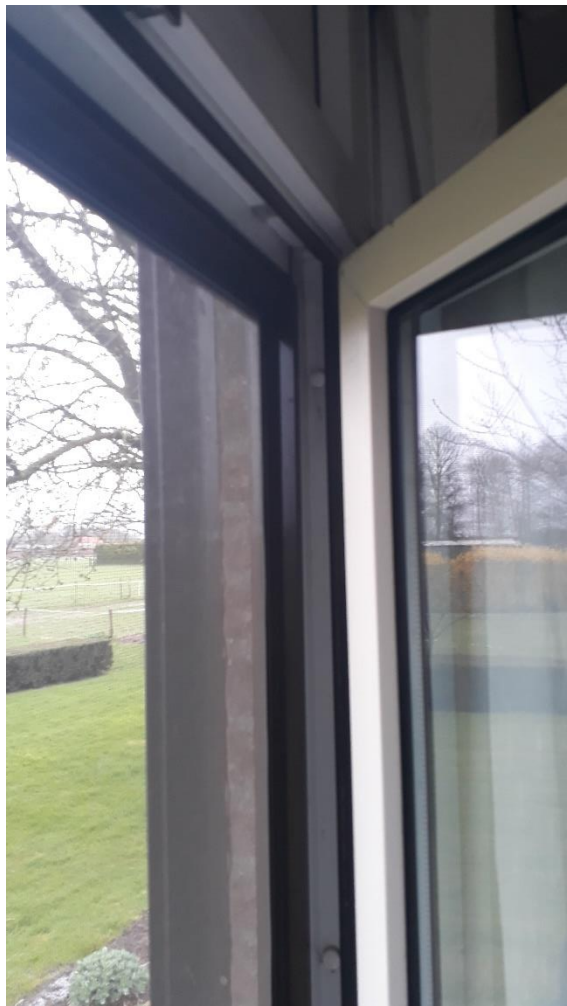
Foto 18 Te openen deel met dubbelglas en kierdichting
