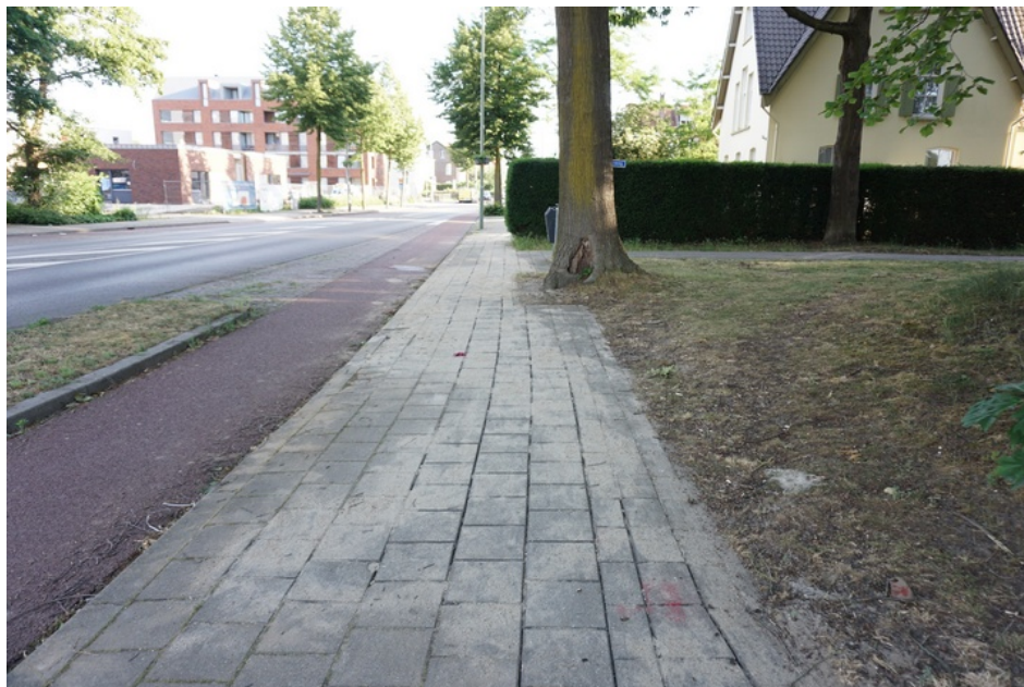
Foto 4: Graafwerkzaamheden zijn uitgevoerd ten behoeve van aanleg glasvezel.
