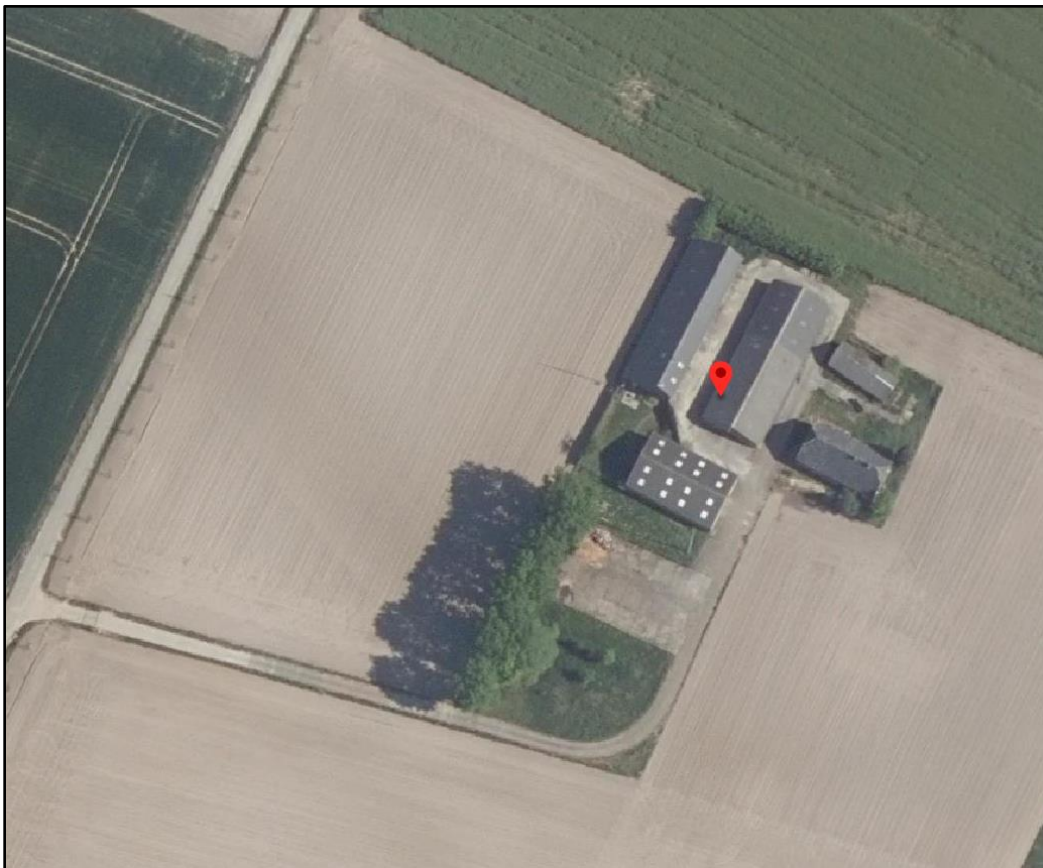
Luchtfoto bestaande agrarische bebouwing Biezendijk 4, alle bebouwing wordt gesloopt
