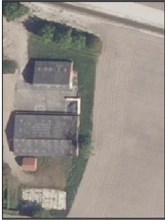
Bestaand: deels te slopen bebouwing
